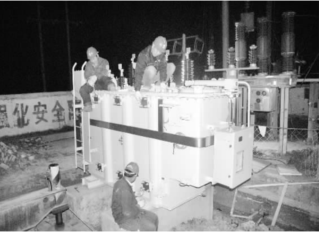
11月4日晚，扶沟县电业局对35千伏坡贾变电站1号主变进行增容改造、满足冬季负荷高峰及春节期间该县汴岗、大新两个乡镇用电需求,实现电网安全和可靠供电。
