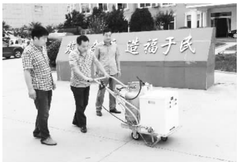
商水县公路管理所多方筹资购买沥青灌缝机等设备和材料,及时组织养护专业队对辖区管养的道路病害实施沥青灌缝作业养护。图为工作人员对沥青灌缝机进行安装调试。(记者 岳建辉 摄)
