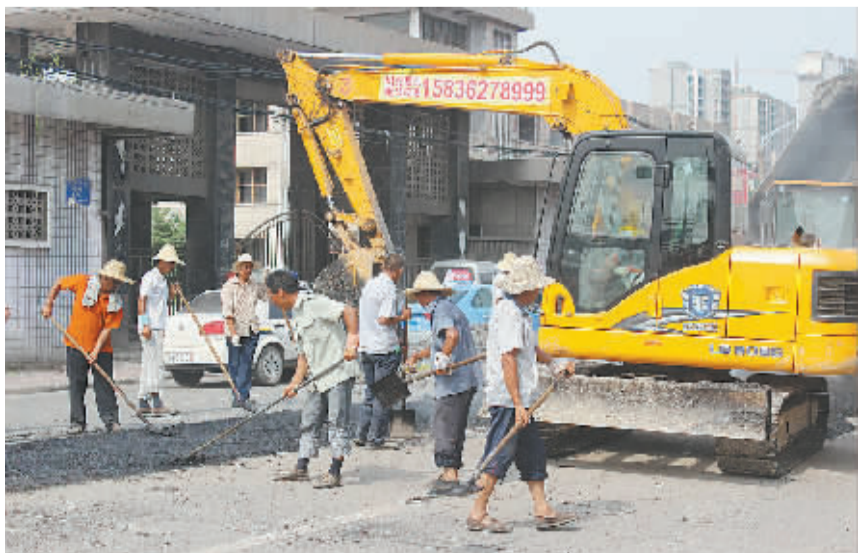
近年来,受车流量增多、雨水冲刷等因素影响,项城市区多条道路出现了坑槽、开裂、变形、破损等现象。近期,项城市城管局通过调查摸底,科学规划,对“窟窿路”、“问题路”进行重新修整,为市民出行提供了方便。图为道路维修人员正在莲花大道东段修补路面。杨光林 朱宁宁 摄
