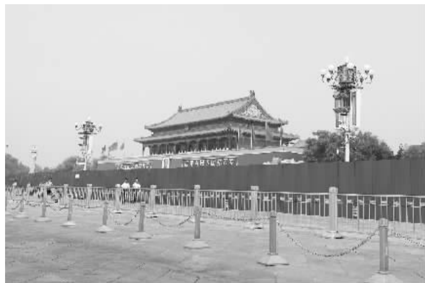
天安门区域为“9·3”阅兵搭建各类设施。这是天安门城楼南侧为修建临时观礼台而搭建的护栏(8月11日报)。
