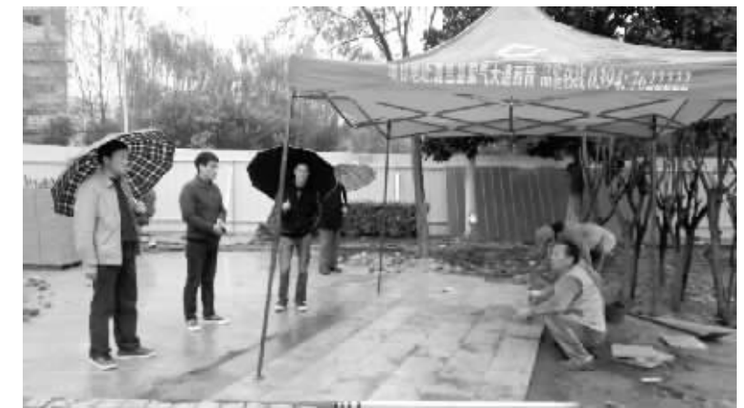
10月27日,施工人员在冒雨铺设消防主题游园地砖。 罗宇摄
