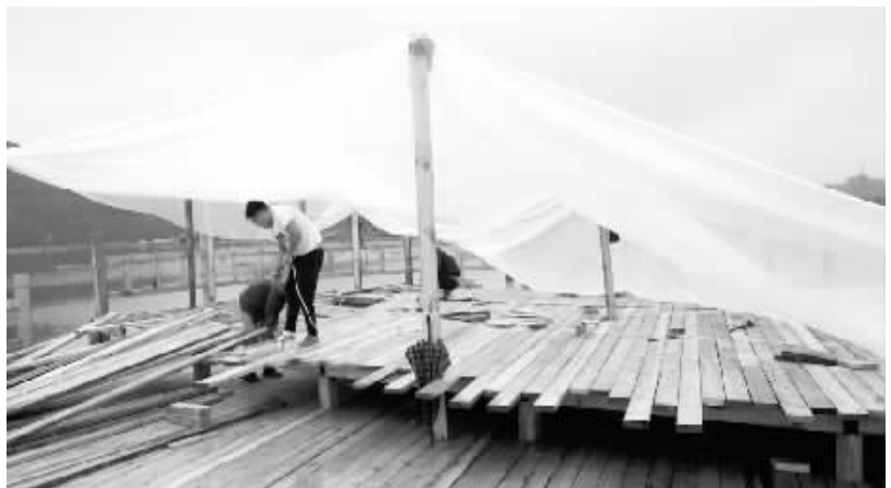
10月24日,施工人员在冒雨铺设上清湖公园步道。 罗宇摄
