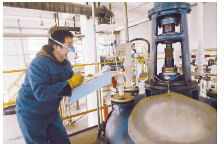
元旦前夕,康达制药有限公司正式投产运行。康达公司占地面积260亩,以生产头孢菌素类原料药为主,拥有22个生产批文,总投资5亿元。项目全部投产后,可实现年产值20亿元,利税3.2亿元。图为技术人员正在生产中观测数据。蒋树保 摄
