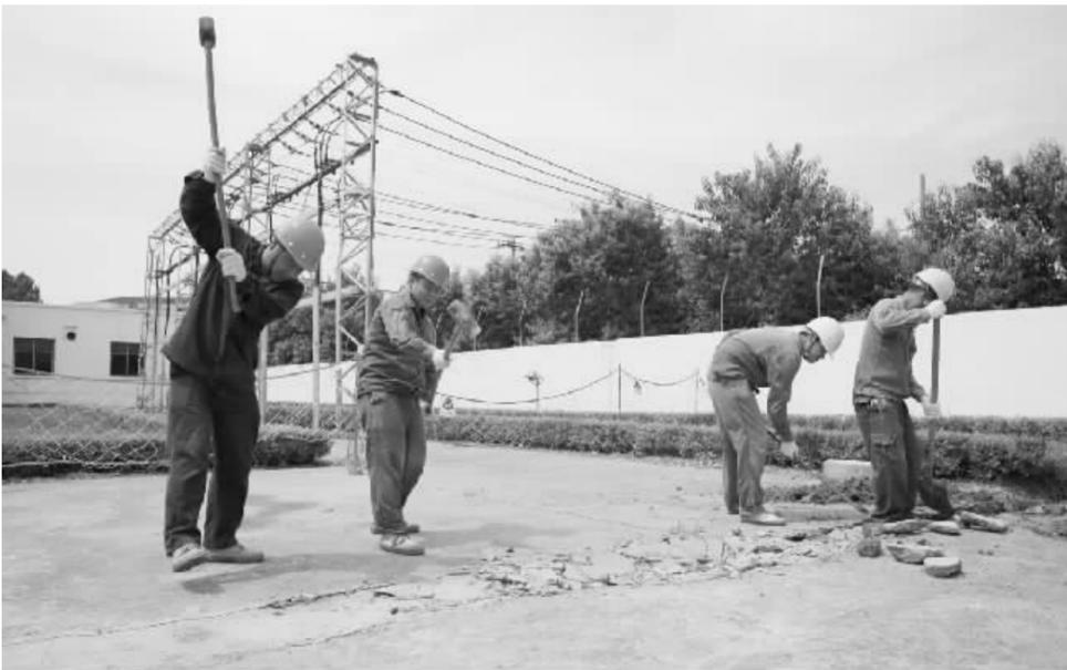
7月19日，扶沟县供电公司运维人员对10千伏扶沟线电缆沟进行开挖，紧急处理该线路电缆因高温天气、负荷突增引起的电缆故障。刘军胜 摄
