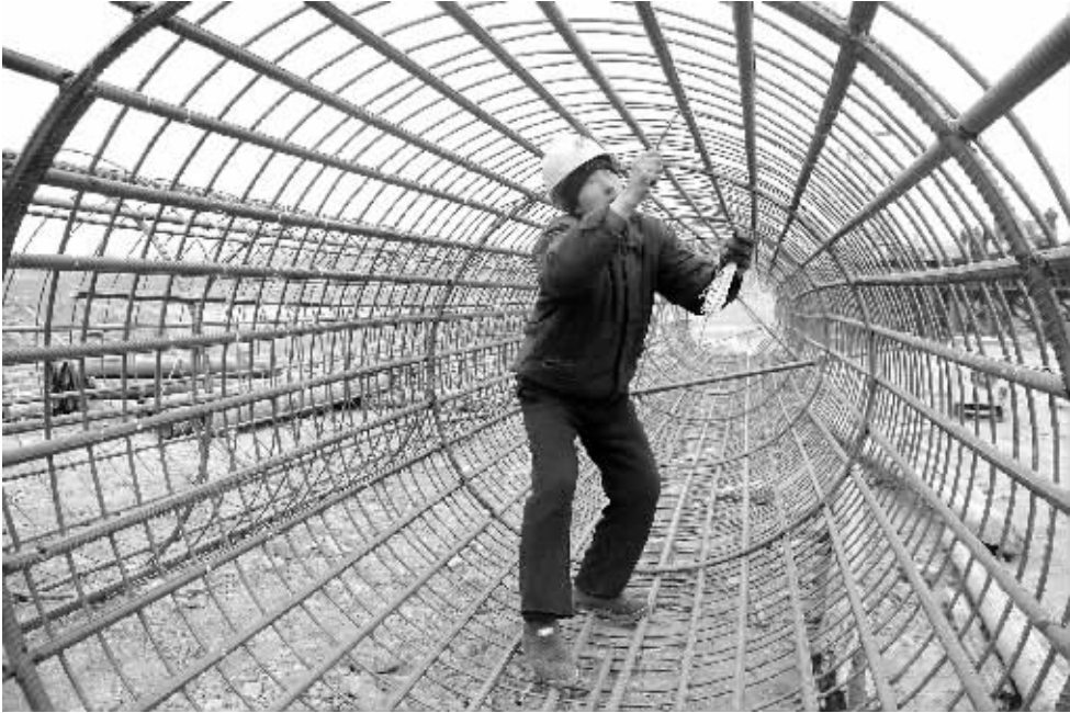
昨天,在市区大庆路大桥建设工地上,工人们冒着严寒加紧施工。一位来自新乡的施工人员说:“为了早日建好桥、方便两岸市民,我们苦点儿也值得!” 晚报记者 朱海龙 摄
