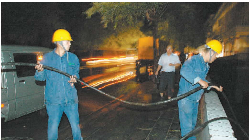
昨晚11时,在市区三连坑泵站,电力人员摸黑抢修线路,保证泵站及时恢复工作。 晚报记者 朱海龙 摄
