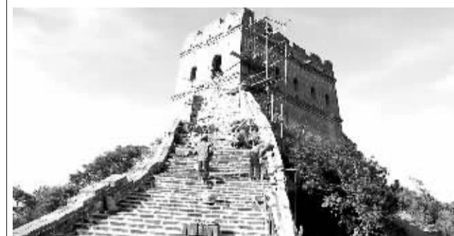
6月13日拍摄的八达岭残长城维修施工现场。近期,施工人员正对北京八达岭东沟段残长城进行修缮。修缮施工采用“修旧如旧”的方法,用旧城砖、老白灰,确保施工后的风格与原有长城相统一。新华社发
