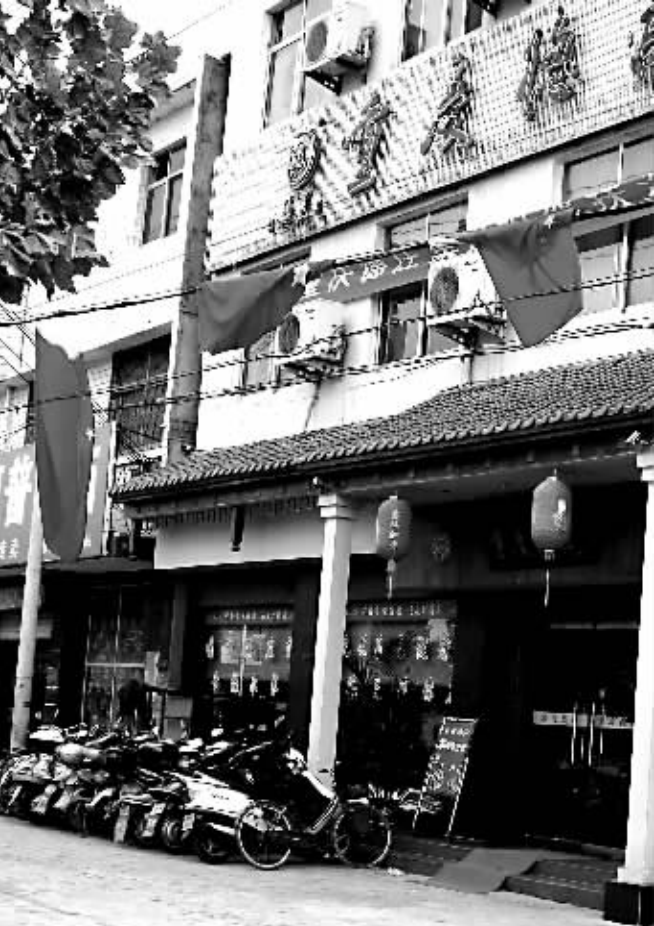
重庆德庄火锅店前的两面国旗紧紧地缠绕在光缆上
