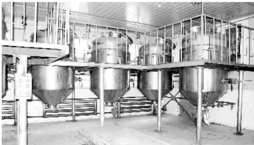
普乐液精炼车间内的设备已处于闲置状态（8月18日摄）。
