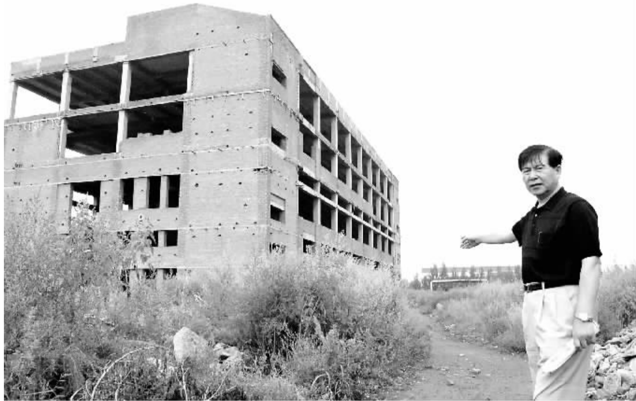
李政俭指着普乐工业园区的半截子建筑，叹息不已（8月18日摄）。
