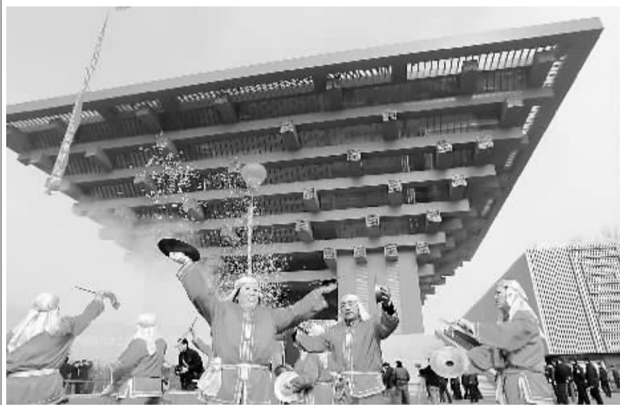
2010年上海世博会标志性建筑中国馆“东方之冠”8日正式竣工。极富中国建筑文化元素的“斗冠”造型以及表面覆以“叠篆文字”的主题构思,令矗立于黄浦江畔的中国馆淋漓尽致地呈现出中华神韵。图为竣工仪式现场。 新华社发
