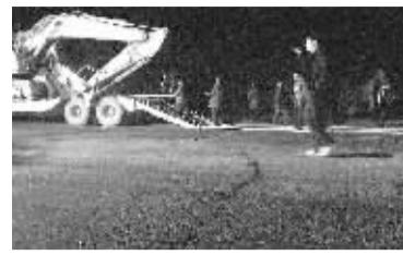
3月18日零时许，大型机械开进昆明机场跑道，对沉降、脱皮严重的板块进行整体更换。当前，云南遭受了百年一遇的干旱天气，导致昆明巫家坝国际机场地下水位降低，跑道道面板块出现沉降、断板、脱皮等现象，严重影响了飞机的起降安全，目前昆明机场正尽力修补受损的跑道。
