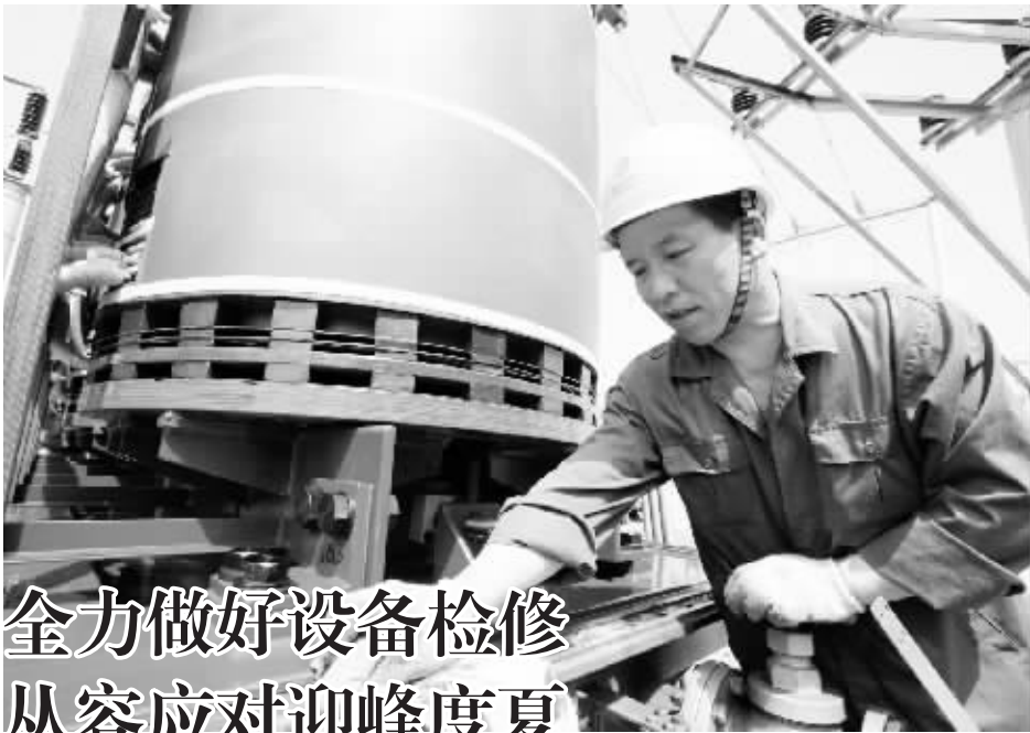
暑期将至,周口供电公司组织技术人员,检修变电站等生产部门的设备,为迎峰度夏打下坚实基础,确保全市高负荷用电安全及时。图为技术人员正在检修设备。 记者 孙安平 摄 线索提供 张继
