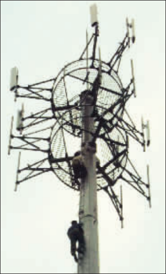
拆除塔上的违章设施
