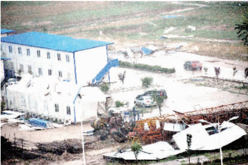
东新区一处工棚被大风掀掉了盖
