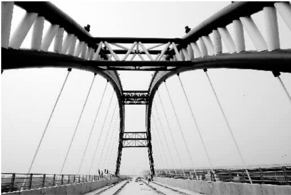
即将完工的郑州黄河公铁两用特大桥(8月4日摄)。
