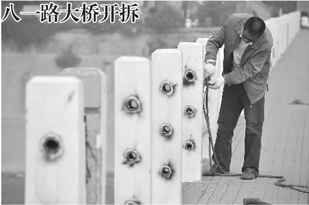
昨天上午，在市区沙颍河八一路大桥上，工作人员正在拆除桥栏。目前，桥上的路灯、通信线路、管道等正在紧张拆除中。
