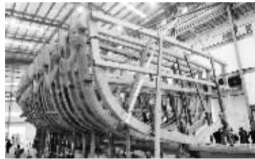
10月20日，工人在安装“仿明代郑和宝船”肋骨。当日，南京郑和宝船厂举行郑和宝船复建庆典，厂区内外，一艘等比例、可进行远洋航行的“仿明代郑和宝船”主体已经复建完成1/3，现场举行了宝船肋骨安放仪式。复建的仿古宝船总长71.1米，排水量1600吨。仿古宝船用中国传统的木船建造工艺建造，计划于2013年进行航行试验。新华社发
