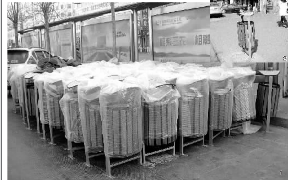
昨日，市环卫处在周口市市区汉阳路等多条主干道安装了一批新的垃圾箱。据了解，此次将安装500个垃圾箱。图1为垃圾箱运抵周口五一广场附近准备安装；图2为六一北路新安装的垃圾箱。
