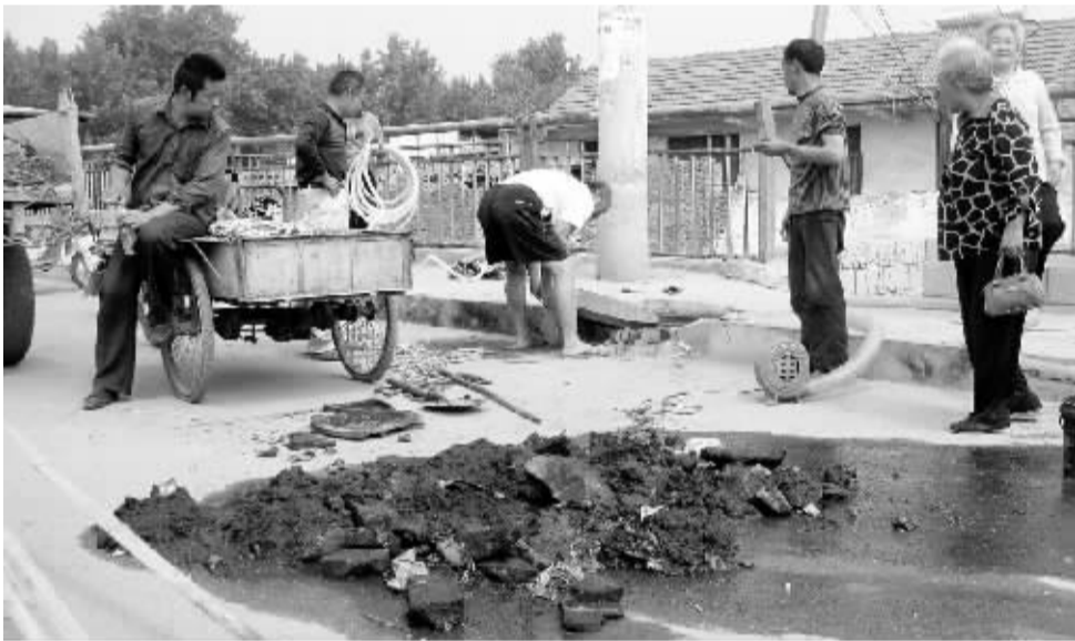
下水道疏通现场
