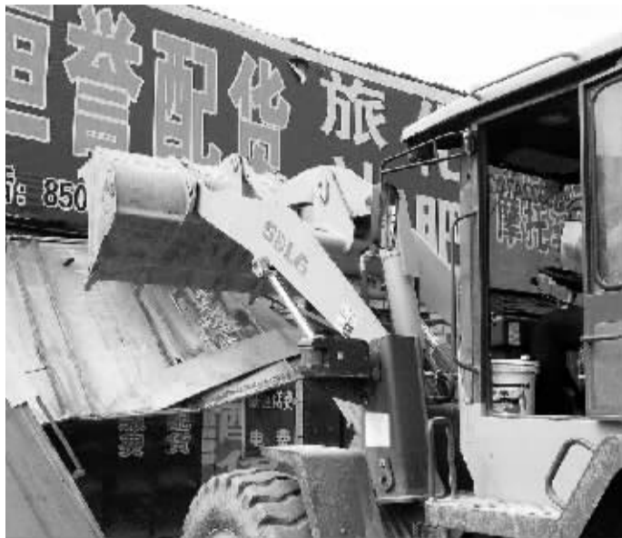
违章建筑拆除现场
