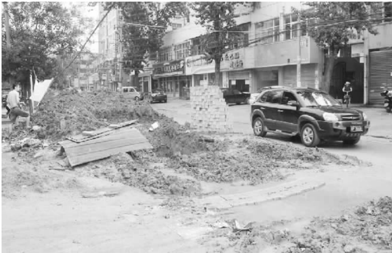
施工路段停工
