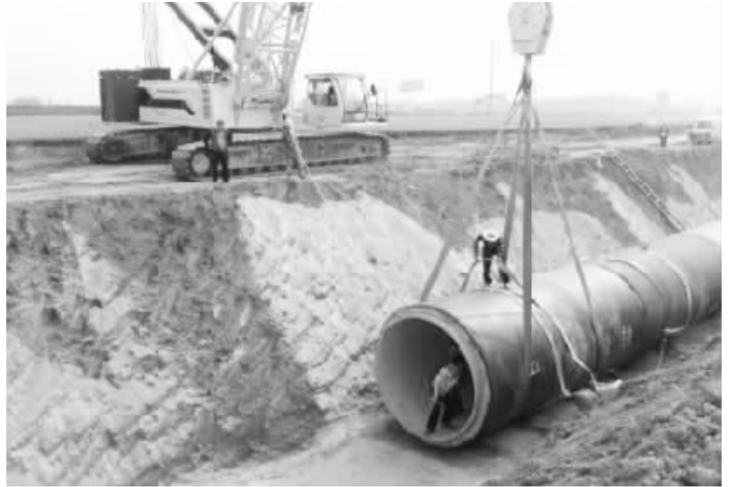
南水北调配套工程施工现场
