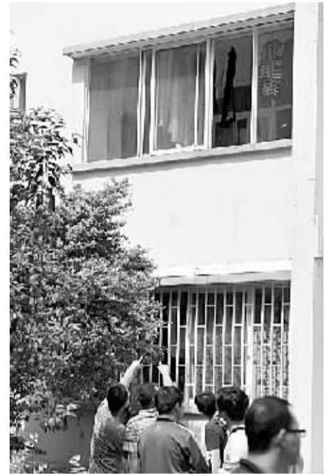
犯罪嫌疑人通过一楼的防盗窗，顺利爬进了二楼的女生宿舍行凶
