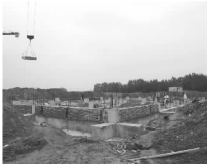
周口市益民小学施工现场
