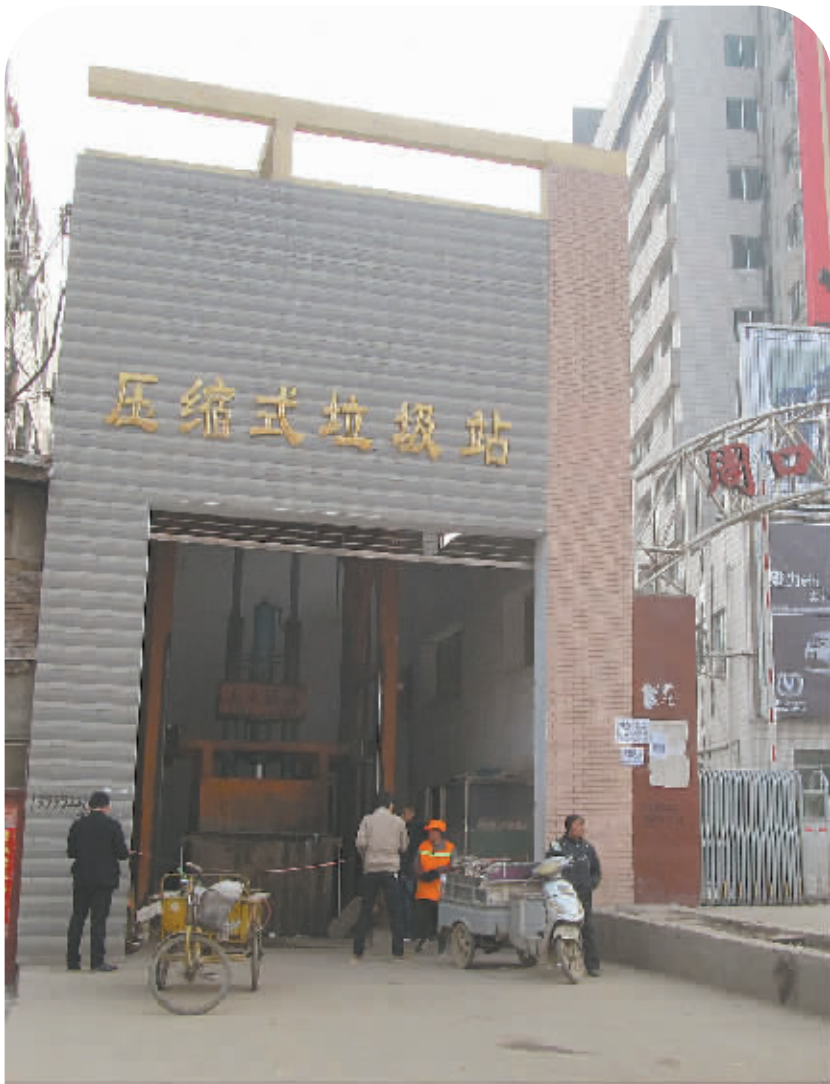
交通大道与中州大道交叉口的垃圾中转站使用的是单机位垂直压缩式垃圾处理方式。
