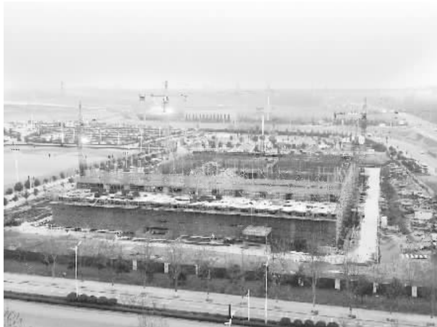
市游泳馆施工现场
